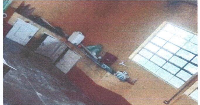
Foto 10: Sustitucion de piso a Pisp granito
