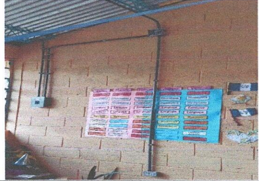
Foto 8: Sustitución del sistema electrico de las 6 aulas
