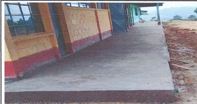
Foto 6: sustitución del Piso
