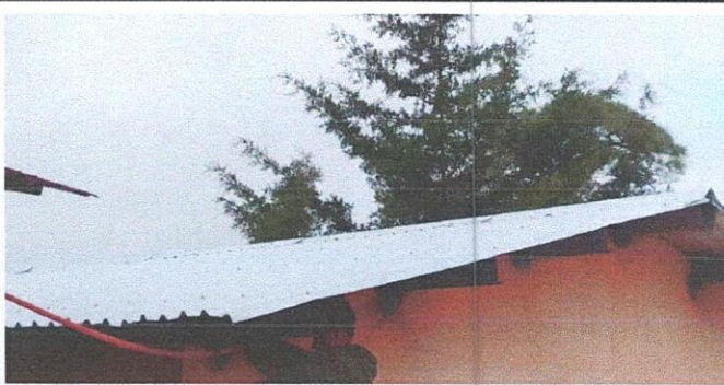
Foto 5: Sustitución de Cables electricos
